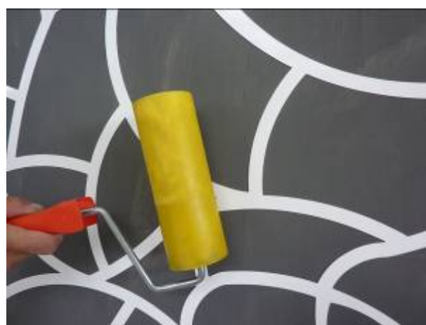
Рисунок 4.21 - Шаг 1. Наклеивание трафарета на обрабатываемую поверхность
