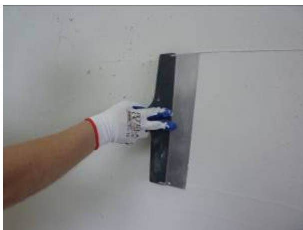
Рисунок 4.9. - Шаг 3. Разравнивание состава шпателем.
