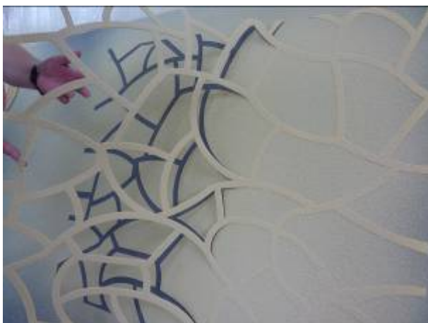
Рисунок 4.19 - Шаг 3. Снятие трафарета по свежему штукатурному составу.
