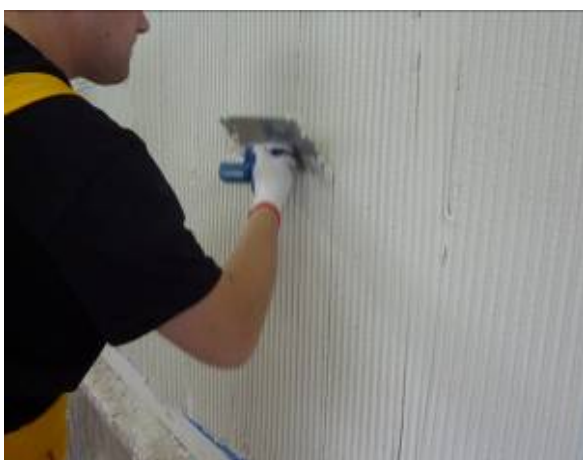
Рисунок 4.8. - Шаг 2. Нанесение при помощи зубчатой терки (величина зуба от 8-10 мм)
