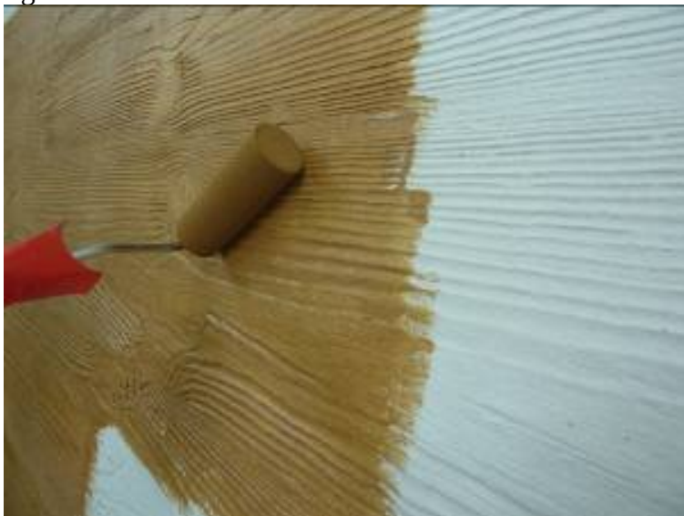
Рисунок 4.16 – Пример нанесения пропитки валиком.
