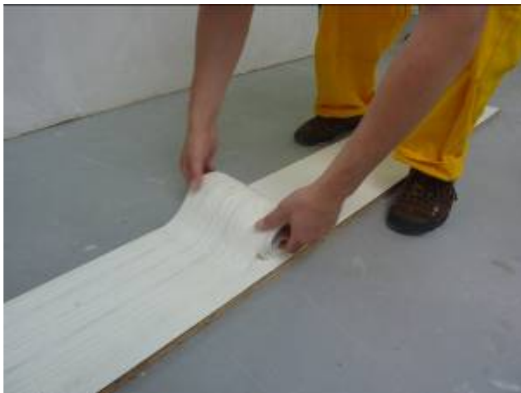
Рисунок 4.13 - Шаг 6. Сворачивание матрицы «под дерево» в рулон фактурной стороной наружу.
