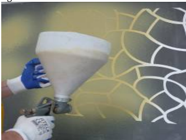
Рисунок 4.18 - Шаг2. Нанесение состава при помощи пистолета-пульверизатора.
