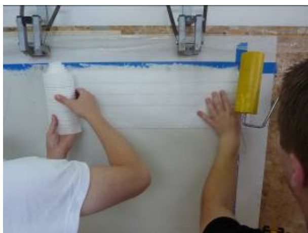
Рисунок 4.14 - Шаг 7. Раскатывание матрицы по свежему составу Ceresit СТ 720 и прижатие при помощи прокатного валика.
