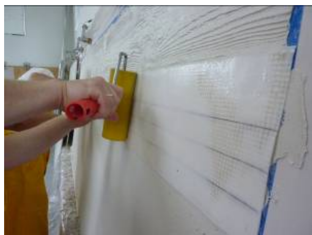
Рисунок 4.14 - Шаг 7. Раскатывание матрицы по свежему составу Ceresit СТ 720 и прижатие при помощи прокатного валика.
