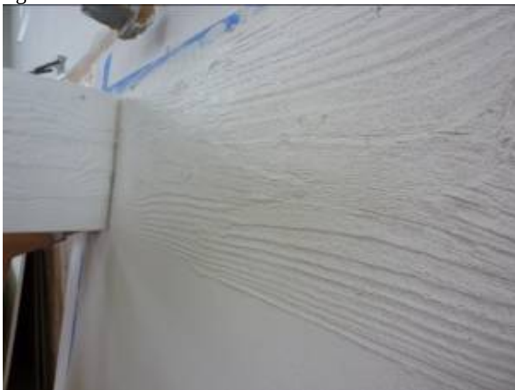
Рисунок 4.15. - Шаг 8. Снятие матрицы после фактурирования состава Ceresit СТ 720.
