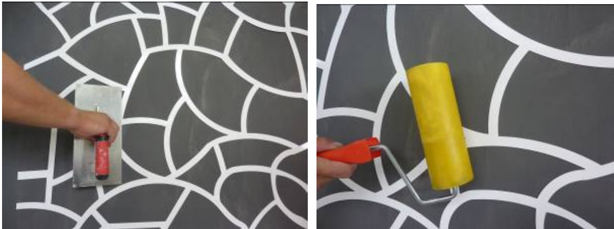
Рисунок 4.17. - Шаг 1. Наклеивание трафарета на обрабатываемую поверхность
