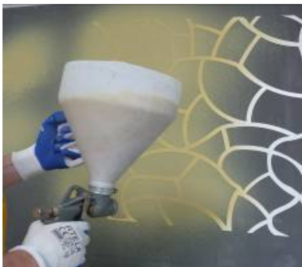
Рисунок 4.2 – Машинный способ нанесения штукатурок
