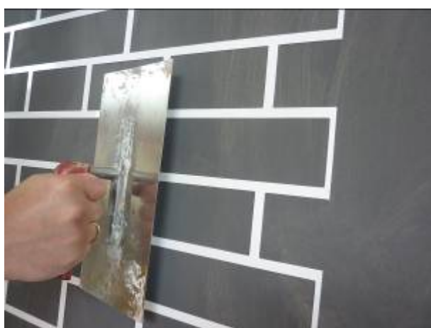
Рисунок 4.21 - Шаг 1. Наклеивание трафарета на обрабатываемую поверхность
