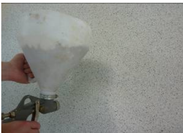
Рисунок 4.3 - Фактура при машинном нанесении (шероховатая)
