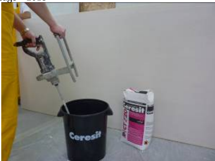
Рисунок 4.7. - Шаг 1. Приготовление состава
