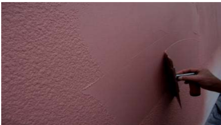
Рисунок 4.5 – Ручной способ нанесения штукатурок
