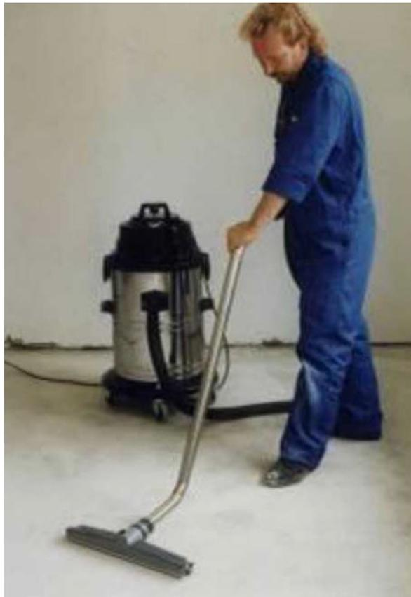
**Рисунок 12 - Обеспыливание основания**
