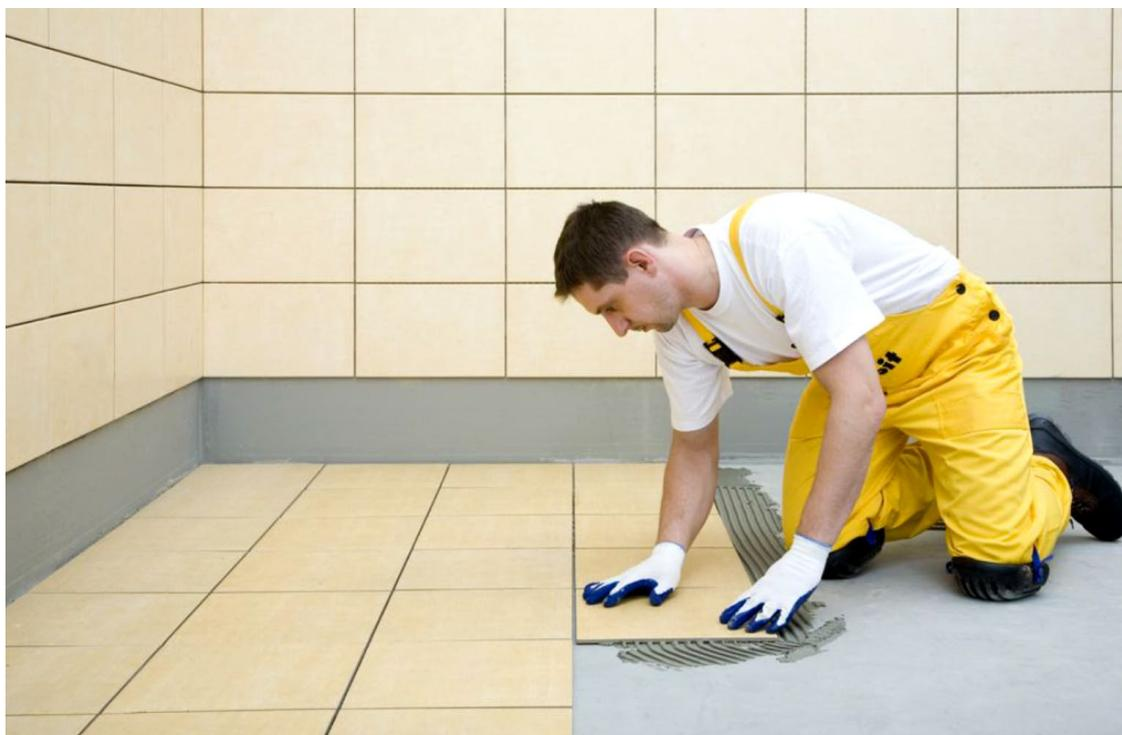
**Рисунок 25 - Укладка плиток на горизонтальные поверхности**
