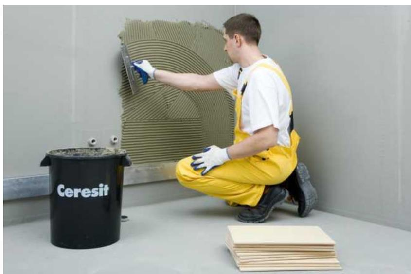
**Рисунок 20 - Нанесение клеящей смеси на основание**
