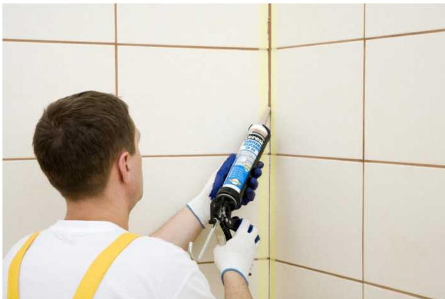
**Рисунок 31 - Заполнение вертикального углового шва**
