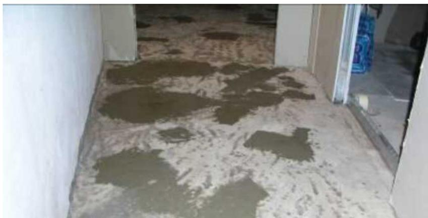
**Рисунок 11 - Ремонт пола составом Ceresit CX5**
