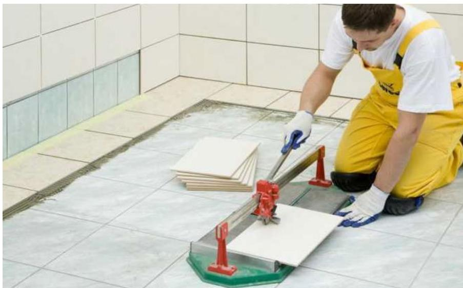
**Рисунок 23 - Резка плитки при помощи плиткореза**
