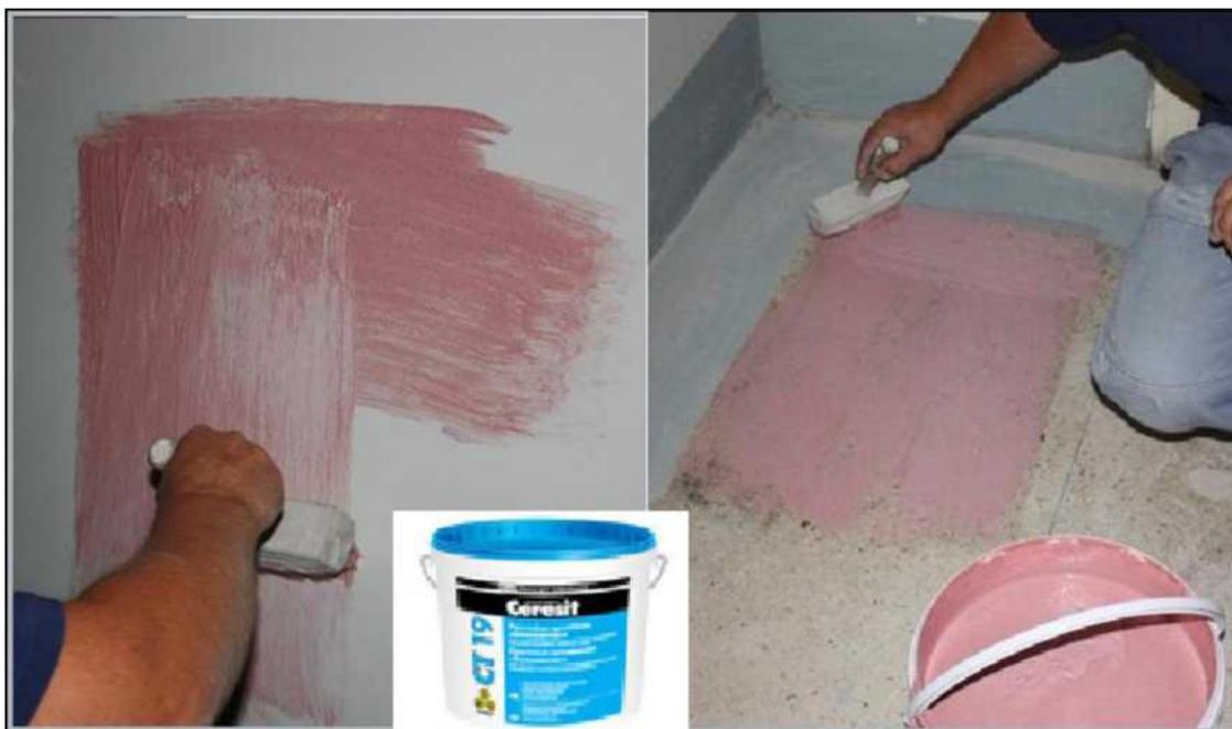
**Рисунок 15 - Обработка масляной краски и мозаичного пола адгезионной грунтовкой «Бетонконтакт» Ceresit CT19**
