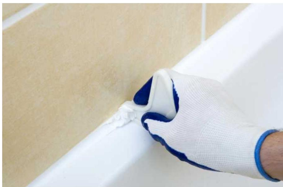
**Рисунок 32 - Заравнивание герметика в шве**
