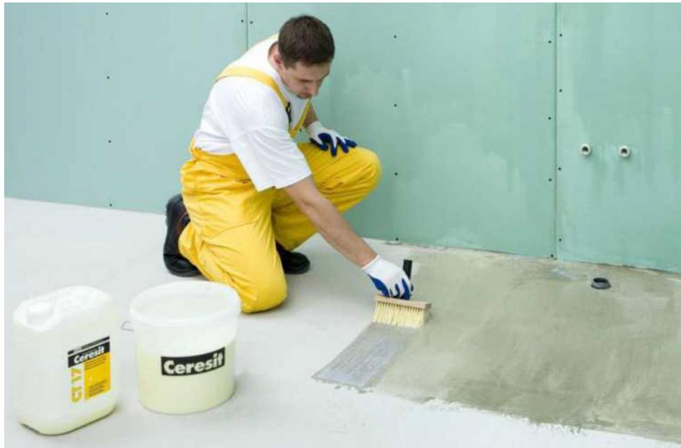
**Рисунок 13 - Обработка впитывающего основания глубокопроникающей грунтовкой Ceresit CT17**
