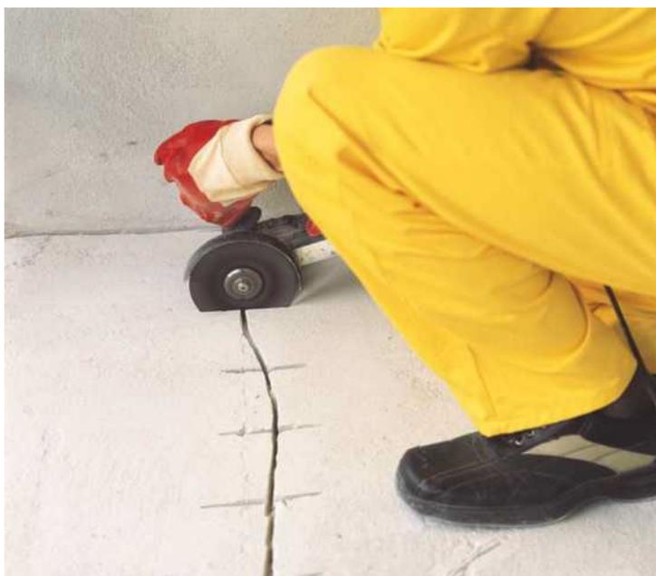
**Рисунок 9 - Расшивка трещин в основании**
