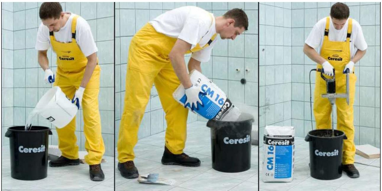
**а) дозирование воды; б) добавление смеси; в) перемешивание**
