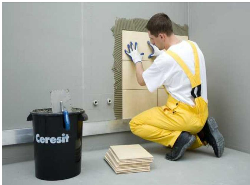
**Рисунок 21 - Приклеивание плитки на стену**
