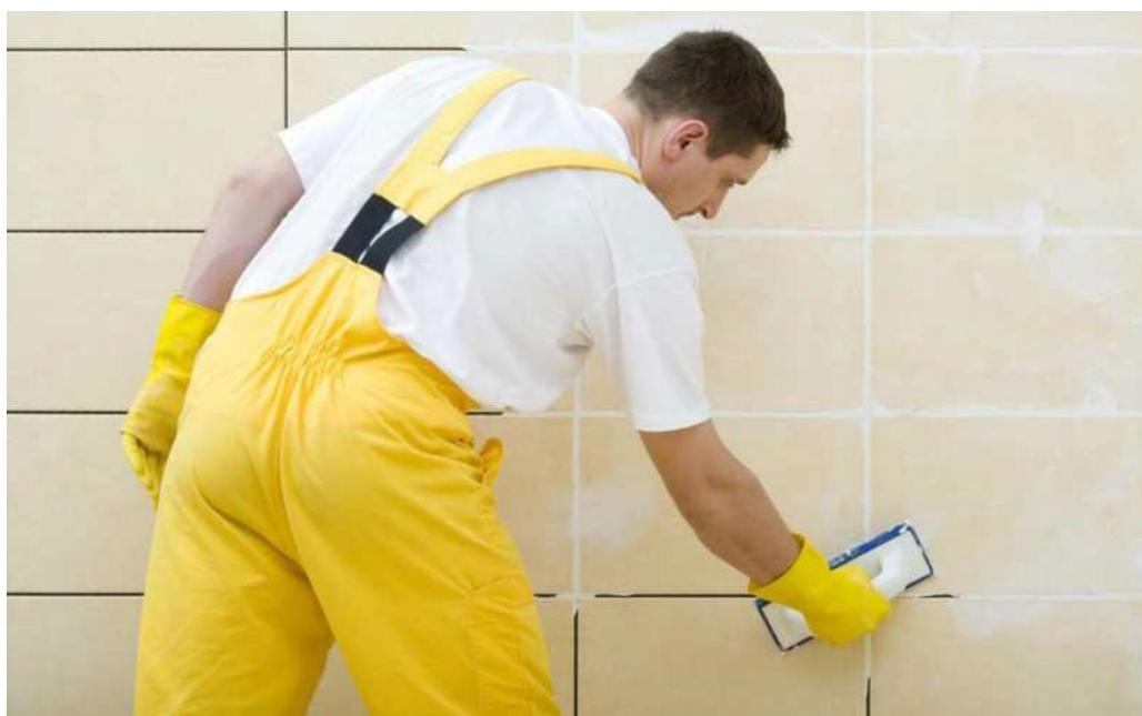
**Рисунок 27 – Заполнение швов между плитками**
