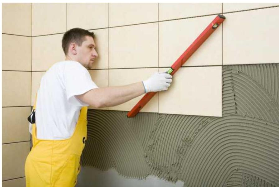
**Рисунок 22 - Проверка облицовки при помощи уровня**
