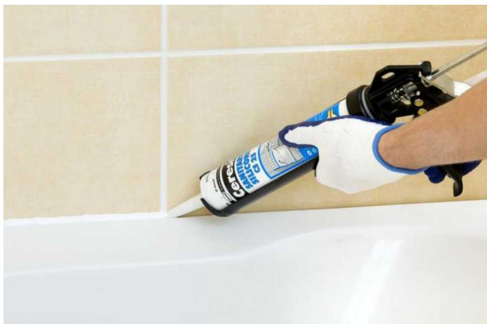
**Рисунок 30 - Заполнение горизонтального шва герметиком**
