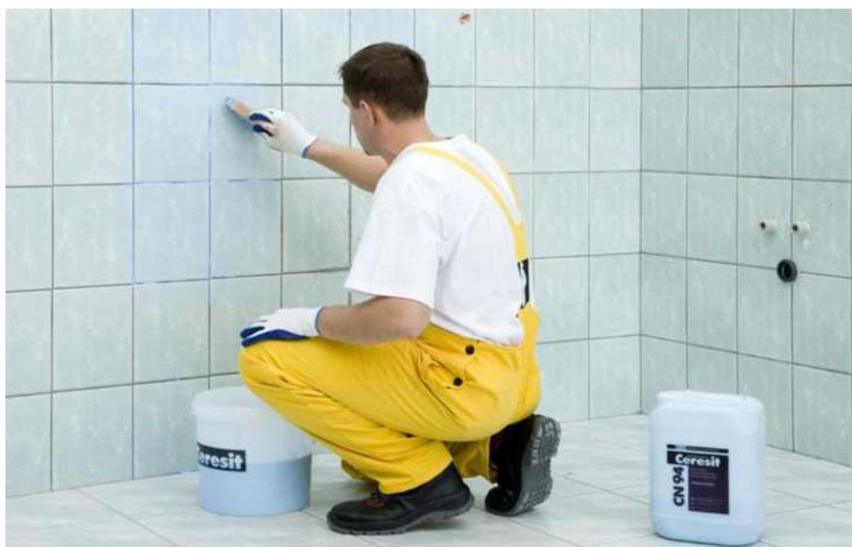
**Рисунок 14 - Обработка плотного основания пленкообразующей грунтовкой Ceresit CN 94**
