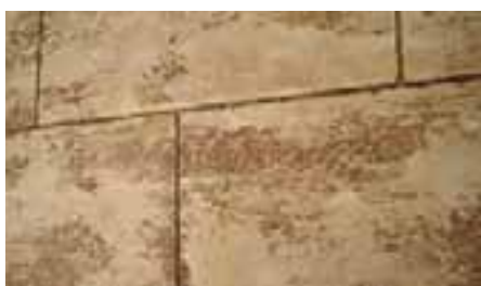
Полиминеральная штукатурка Ceresit СТ 36, инструмент нанесения: стальная терка, инструмент фактурирования: Венецианский шпатель, кисть.
