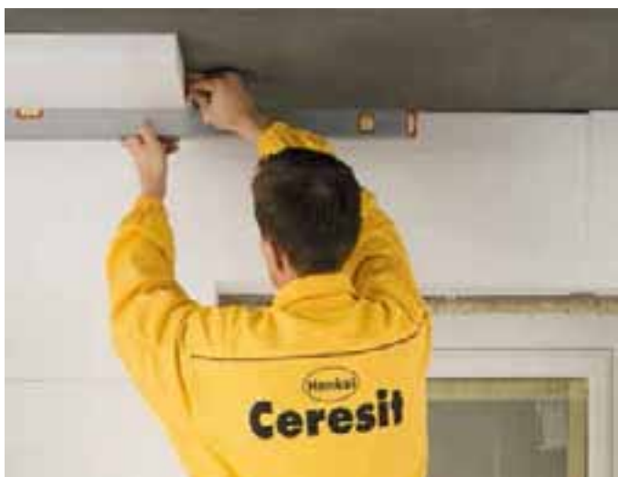
24 Монтаж дополнительных элементов крепления на горизонтальных поверхностях (например, на потолок балкона)
