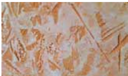
Полиминеральная штукатурка Ceresit СТ 36, инструмент нанесения: стальная терка, инструмент фактурирования: Венецианский шпатель, шпатель.
