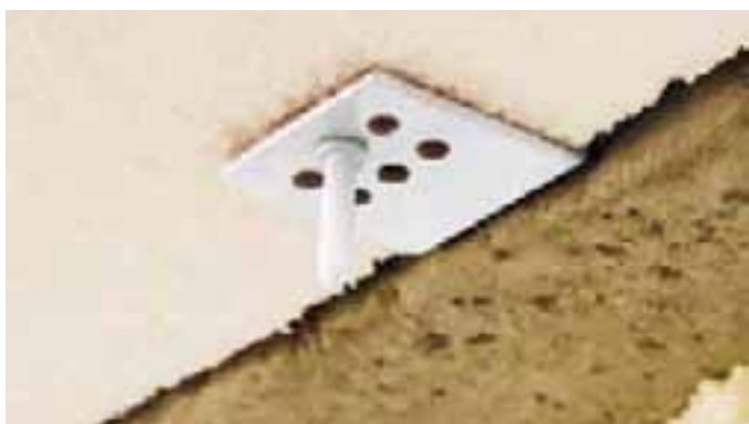
24 Монтаж дополнительных элементов крепления на горизонтальных поверхностях (например, на потолок балкона)
