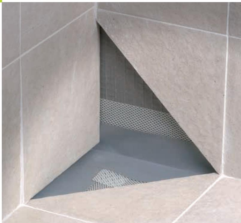
**BANDTEC Dichtband aus thermoplastischem Elastomer**
