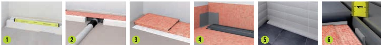
Prüfen Sie die Stärke des Verlegungsmaterials. Prüfen Sie die Abmessungen des Orts an dem der Abfluss positioniert werden soll, schneiden Sie den Styroporkörper zu und kleben sie diesen entsprechend an. Schneiden Sie das mittlere Stück für den Ausgang der Rohrleitung aus.
