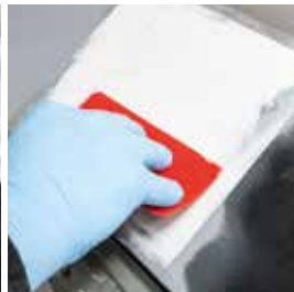
Ultrafijne afwerkingsplamuur TEROSON UP 260 aanbrengen
