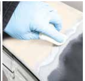
BONDERITE M-NT 1455 W aanbrengen, alleen op blank metaal. Verdamping gedurende 5 min vóór het lakproces
