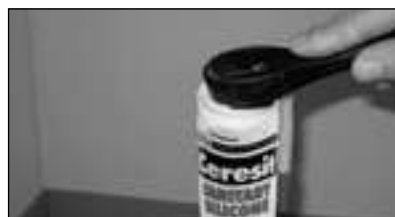
Cu ajutorul lamei incluse se desigilează cartușul la partea superioară, deasupra filetului
