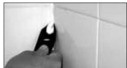
Îndepărtarea surplusului de etanșant din rost
