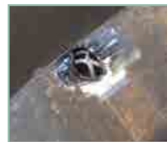
金網が補修部分を補強し、エポキシ補修剤の裏あてとなります。
