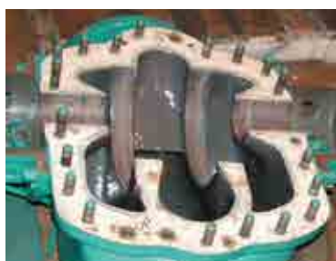
補修完了し再組み付け準備完了
