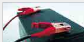
バッテリーケーブル固定
