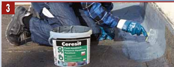
3 Aplicați primul strat de Ceresit CP 30 cu o bidinea sau cu o rolă.
