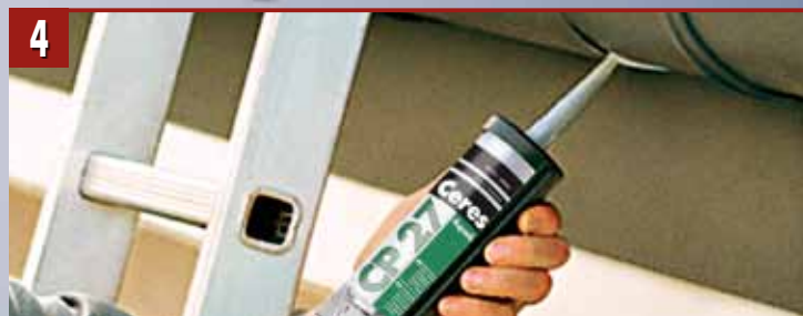
4 Ceresit CP 27 se folosește cu succes și la repararea micilor găuri sau fisuri, de exemplu la repararea iğheaburilor.
