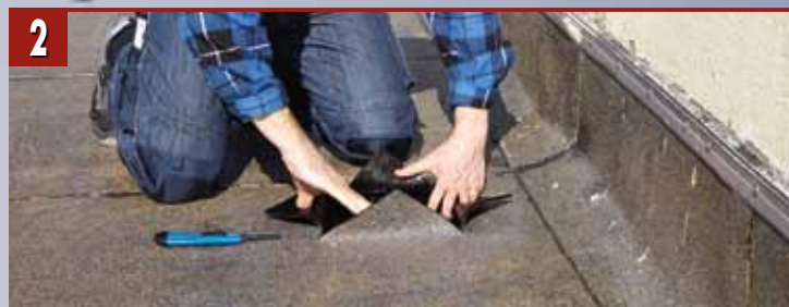
2 Tăiați cu grijă partea care trebuie reparată.
