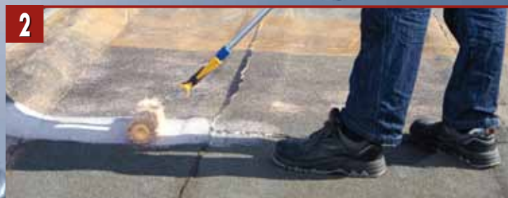
2 Aplicați amorsa Thomsit R 766 cu o bidinea sau cu o rolă.
