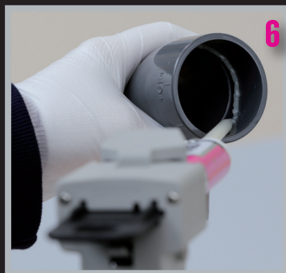
Klebstoff auf die Innenseite des Fittings auftragen.
