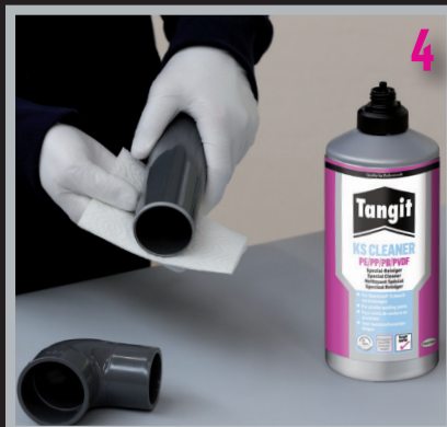
Reinigung von Rohr und Fitting.
