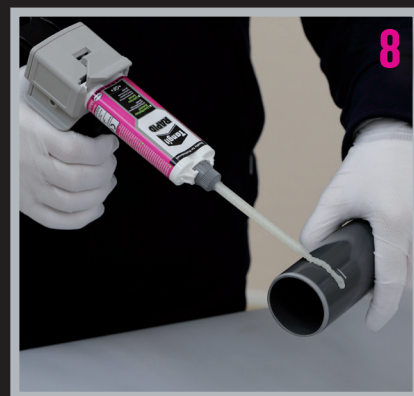
Klebstoff auf das Rohr auftragen.
