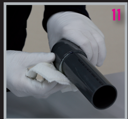
Klebewulst kann abgewischt oder als Qualitätsnachweis belassen werden.
