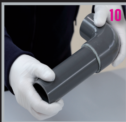
Rohr und Fitting verbinden und kurze Zeit zusammenhalten.
