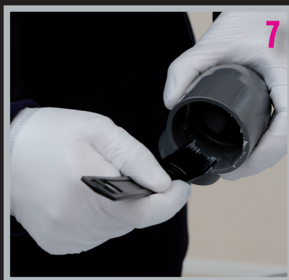
Klebstoff im Fitting mit dem Kunststoffpinsel verteilen.
