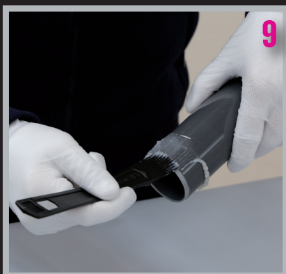
Klebstoff auf dem Rohr mit dem Kunststoffpinsel verteilen.
