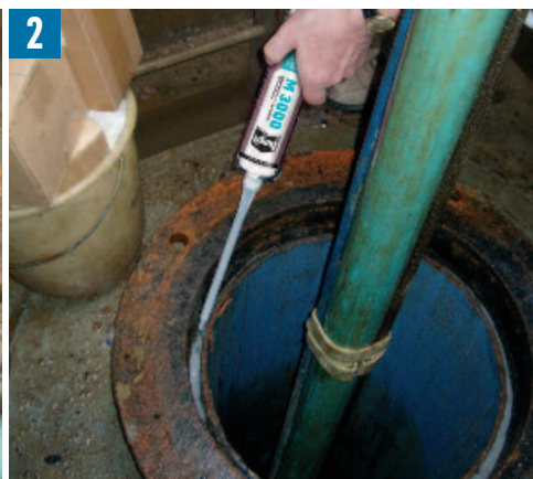
Einfüllen des Expansionsharzes in die Fuge
