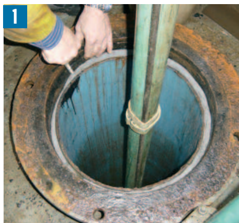
Einlegen des Tangit Dichtschlauchs
