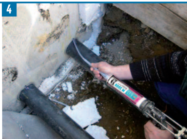
Bild 4 Einpressen des Tangit Expansions- harzes M 3000
