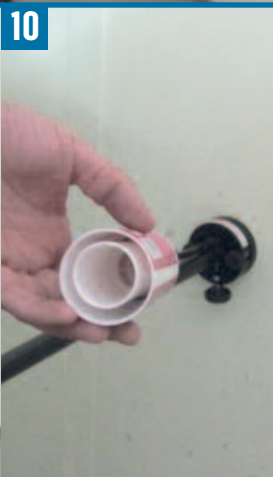
Bild 9+10: Tangit-Kartusche wird in die Kartuschenpistole eingelegt und das Expansionsharz komplett in die MIS injiziert.
