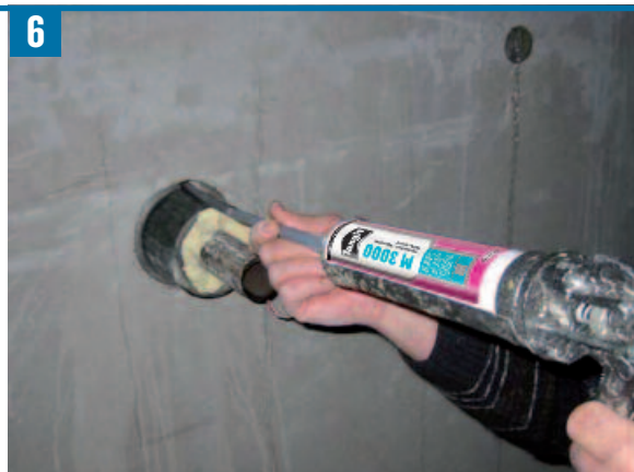
Bild 6 Verfüllen mit Tangit Expansionsharz M 3000 im Innenbereich
