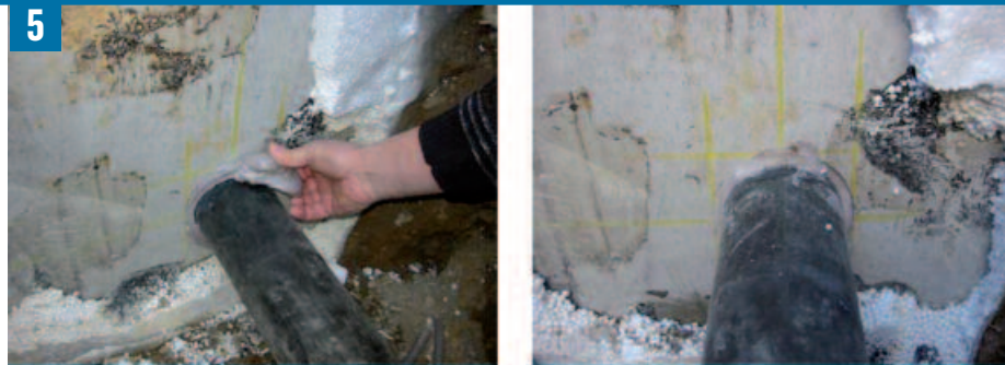
Bild 5 Entfernen des Tangit Expansionsharzes M 3000 und der PE-Rund- schnur (links), fertige Abdichtung (rechts)
