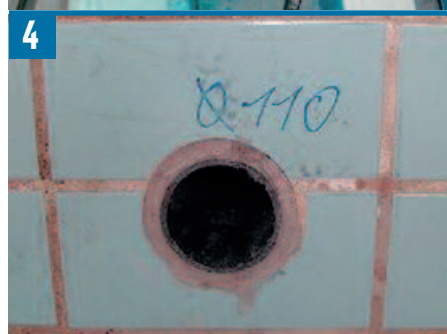
Endmontagezustand des Tangit-Systems
