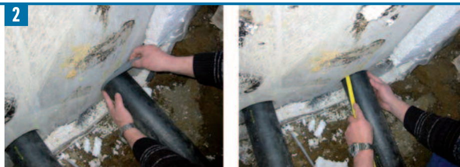
Bild 2 Montage des Tangit Dichtschlauchs M 4082
