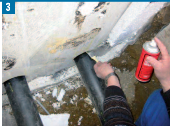
Bild 3 Beschichtung der KMR-Rohre mit Teflon
