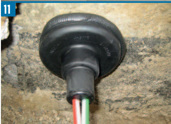
Bild 11: Von der Gebäudeaußenseite werden nun die Micro-Pipes durch die Bohrungen des Außenflansches eingeführt.
