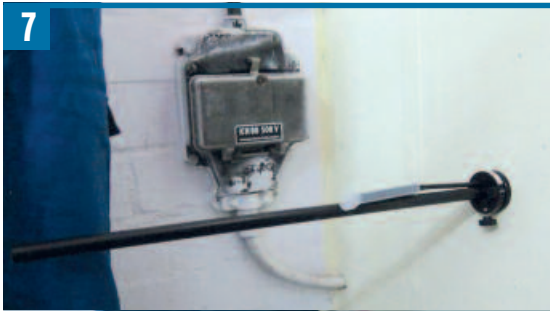
Bild 7: der Harzeinfüllschlauch wird auf ca. 150 mm (gemessen ab der Gebäudeinnenwand) abgelängt und die Mischdüse am Ende bis zum Anschlag eingeführt.
