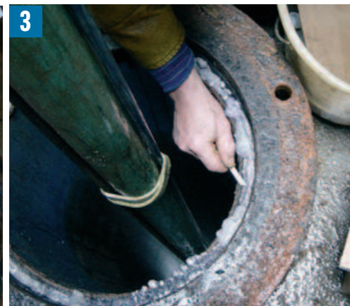
Ausgehärtetes Tangit M 3000 wird abgeschnitten
