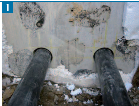
Bild 1 KMR-Fernwärmerohre im Rohrgraben
