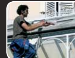
Поправки на покрива
