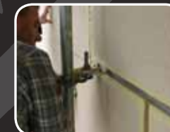
Уплътняване на дилатационни фуги
