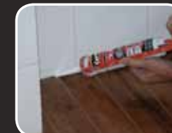
Уплътняване на вътрешни съединителни фуги (дърво/плочки)
