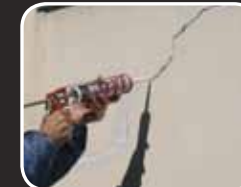
Запълване на пукнатини /на открито и закрито/
