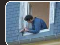
Запечатване на фуги около прозорци
