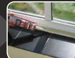
Уплътняване на прозорци отвътре
