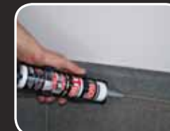
Запечатване на съединителни фуги (бетон)
