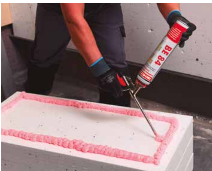
Fijación de paneles EPS en Sistema Bemezcla EIFS.
