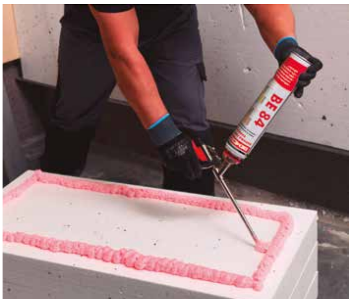
Fijación de paneles EPS en Sistema Bemezcla EIFS.
