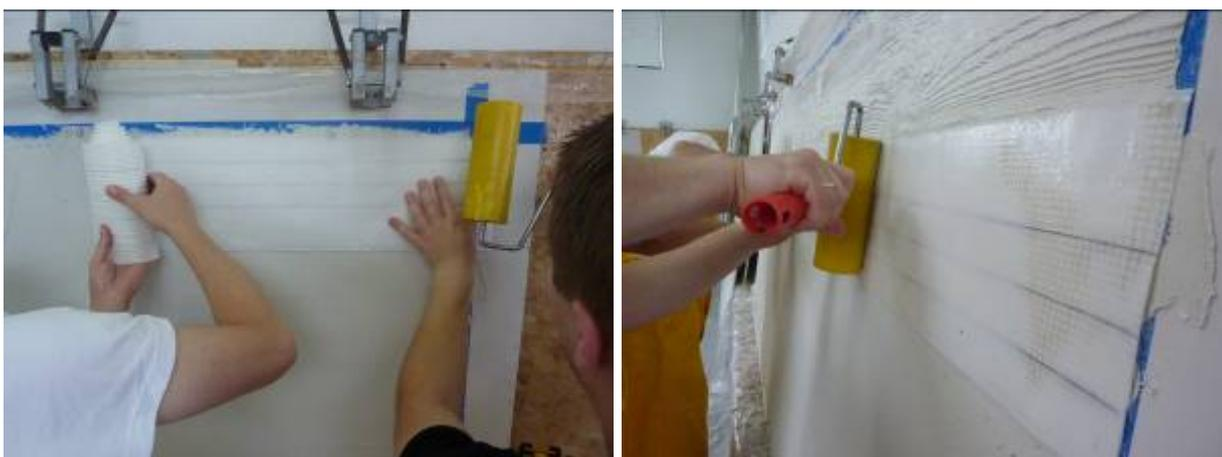
Рисунок 4.14 - Шаг 7. Раскатывание матрицы по свежему составу Ceresit СТ 720 и прижатие при помощи прокатного валика.
