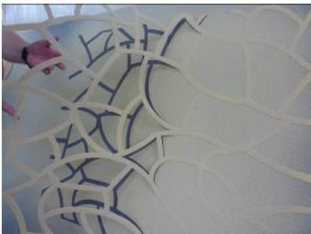
Рисунок 4.19 - Шаг 3. Снятие трафарета по свежему штукатурному составу.
