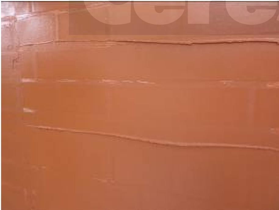
Рисунок 4.23 - Шаг 3. Загладить состав при помощи металлической терки.
