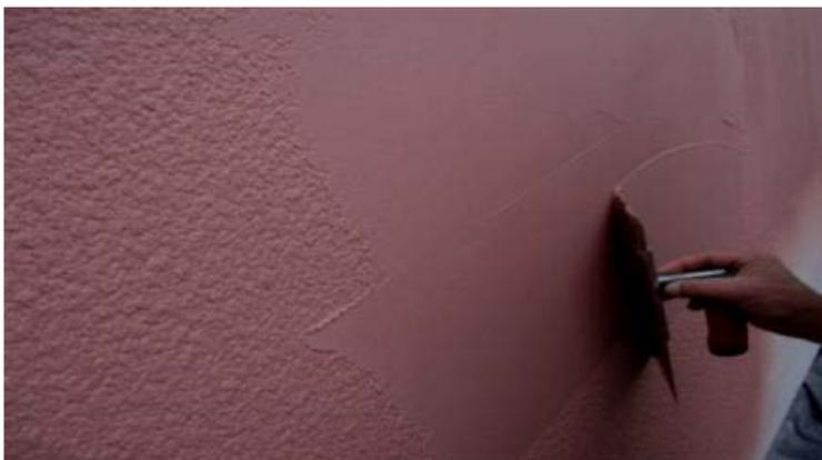
Рисунок 4.5 – Ручной способ нанесения штукатурок
