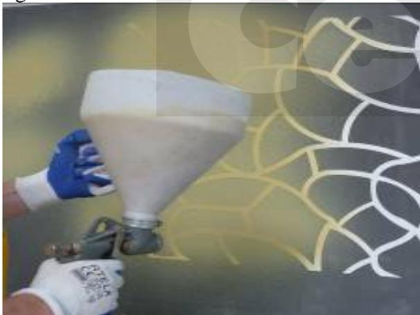
Рисунок 4.18 - Шаг2. Нанесение состава при помощи пистолета-пульверизатора.
