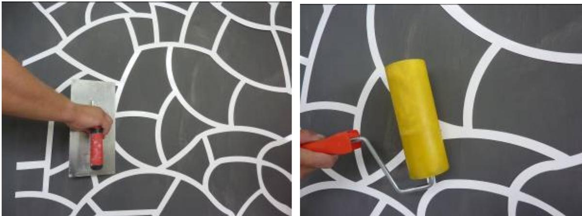
Рисунок 4.17. - Шаг 1. Наклеивание трафарета на обрабатываемую поверхность
