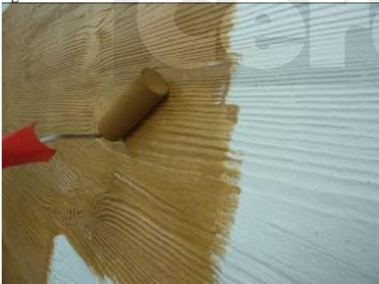
Рисунок 4.16 – Пример нанесения пропитки валиком.
