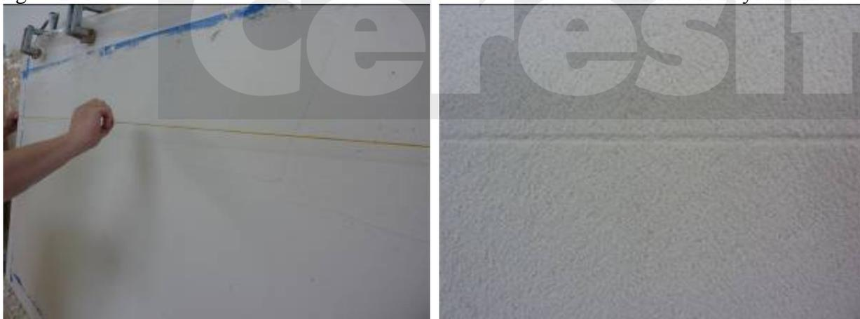
Рисунок 4.10 - Шаг 4. Разметка поверхности при помощи шнура на ширину применяемой матрицы (ширина «доски»).
