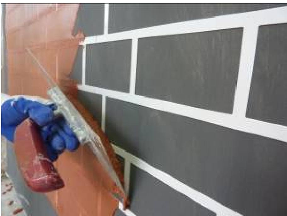
Рисунок 4.22 - Шаг 2. Нанесение состава при помощи металлической терки.
