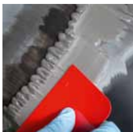
Fördelning av TEROSON EP 5010 TR
