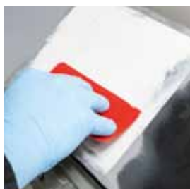
Påføring af finspartel TEROSON UP 335 FF
