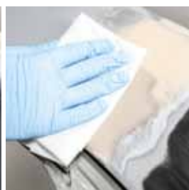
Skal fordampe i 5 min., før det overmales
