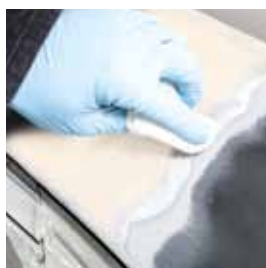
BONDERITE M-NT 1455 W må kun påføres på rent metal. Skal holdes vådt i 2 min.
