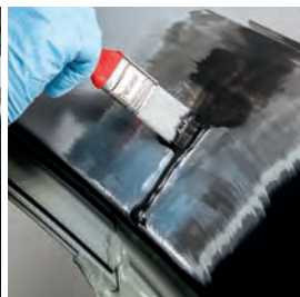
Rozstrek ochrannej vrstvy s TEROSON EP 5055
