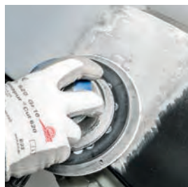
Brúsenie na dosiahnutie hladkého povrchu
