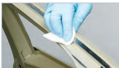
Rýchla a vhodná príprava povrchu
