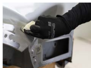
Optionales Auftragen von BONDERITE M-NT 1455-W auf blanke Metalloberflächen. Ca. 5 Min. ablüften lassen.
