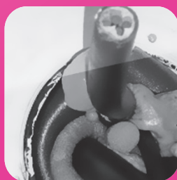
.. voer de buis in en verzegel aan beide kanten met M 3000 – klaar!
