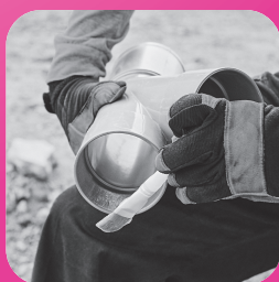
De pvc-lijm kan met een zachte verkwast worden aangebracht.
