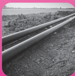
Installation de tuyaux d'évacuation des eaux usées dans le génie civil.
