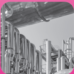
Construction d'usines chimiques ou de transformation des métaux.
