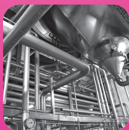
Construction d'usines de produits chimiques et de systèmes de réfrigération.
