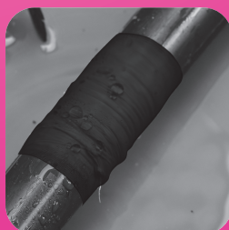
Réparation temporaire des systèmes de tuyauterie.
