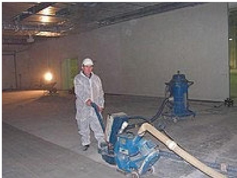
Рисунок 4.2 – Дробеструйная обработка бетонного основания
