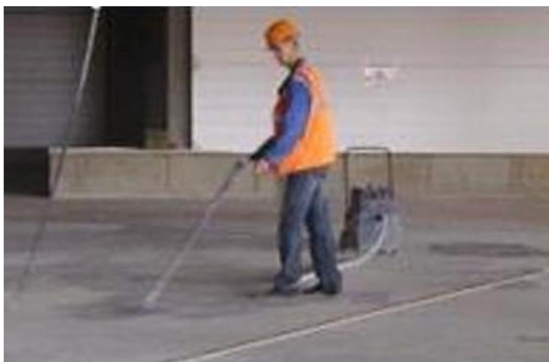
Рисунок 4.3 – Обеспыливание поверхности основания при помощи промышленного пылесоса
