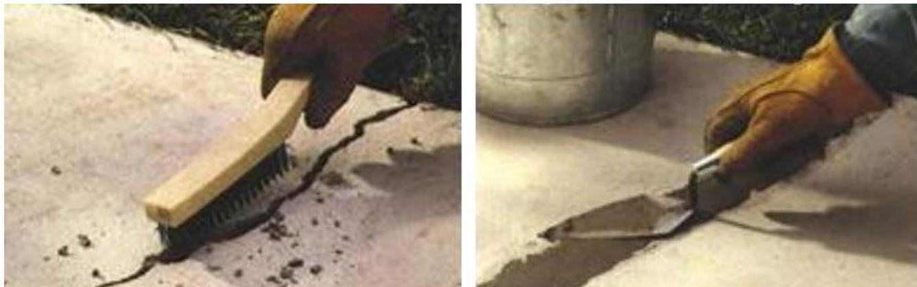
а – Очистка расшитой трещины б – Заполнение трещины
