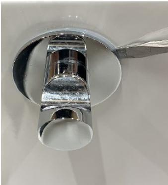
Die Verklebung kann durch Anwendung von Hebelkraft mit einem geeigneten Werkzeug wie z. B. einem (Schlitz-)Schraubendreher oder einem Stielspachtel gelöst werden.
