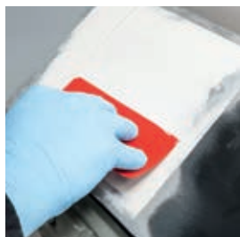
Peenpahtli Teroson UP 260 või Teroson UP 270 pealekandmine
