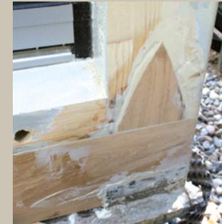
Abschleifen der überstehenden Spachtelmasse und Anschleifen der Fläche vor Neubeschichtung
