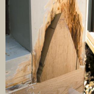
Anpassen eines Passstücks zum Substanzausgleich
