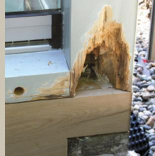
Substanzverlust an Holzfensterkonstruktion
