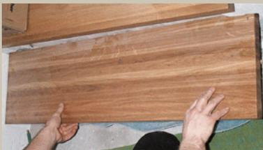
Auflegen und Ausrichten der Treppenstufe im Zeitfenster von 2 Minuten (verzögerte Startreaktion)
