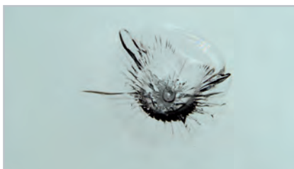
b) razdrobljena poškodba
