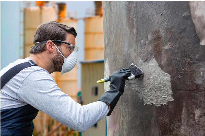
Impermeabilización de un tanque de concreto con Fester CR-Nanotech 99+
