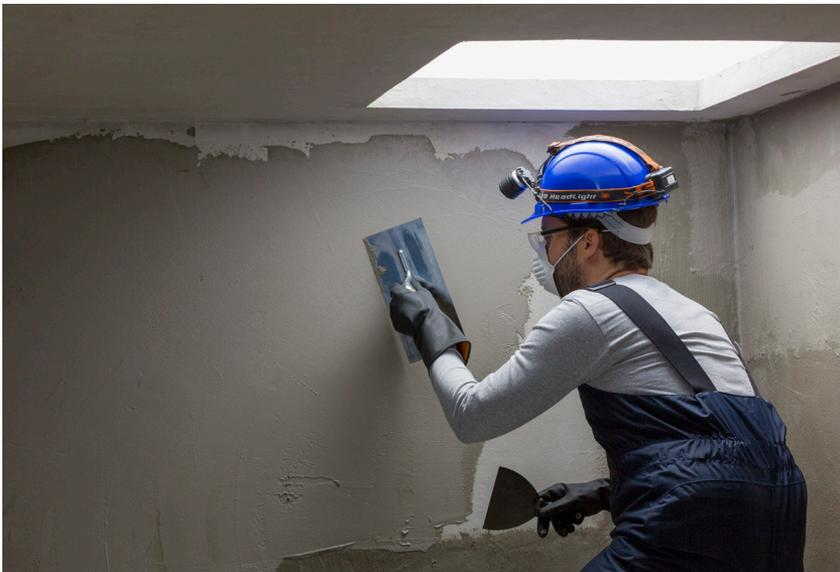
Impermeabilización de una cisterna con **Fester CR-66 Fibre Force**
