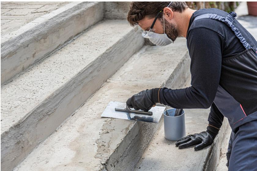
Reparación estructural de elementos de concreto con Fester CM-201
