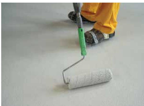
Csúszásmentesített, szemcsehintéssel ellátott bevonat fedőbevonatának felhordása
