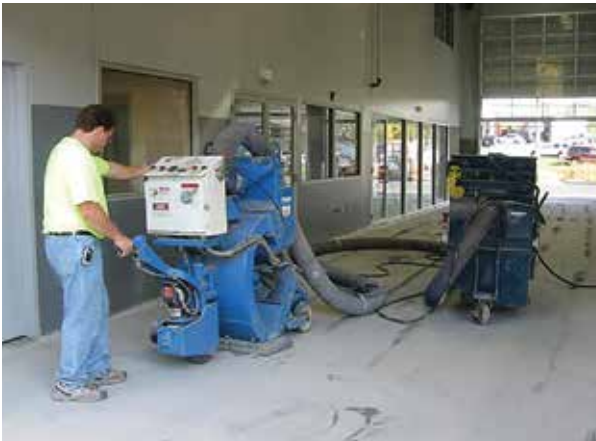
Beton alapfelület szemcseszórásos felület előkészítése
