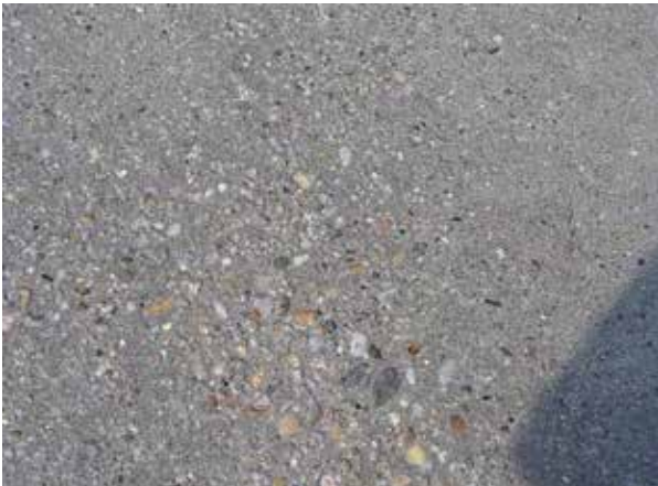
Megfelelően előkészített cement bázisu alap - felület
