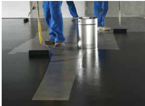
Az előkészített alapfelület alapozása
