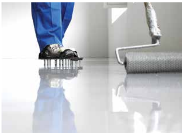
Öntött bevonat légtelenítése tűskés hengerrel
