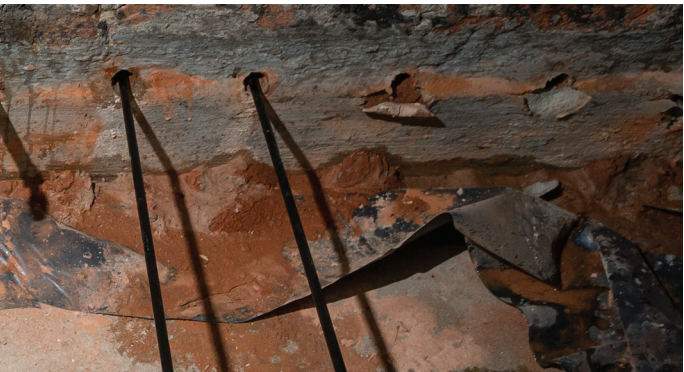
Kontrola głębokości i zachowania kątów podczas wiercenia
