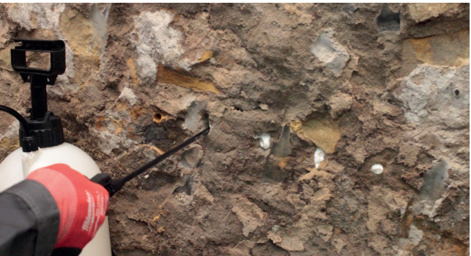
Aplikacja kremu iniekcyjnego CR 82 przy pomocy opryskiwacza ogrodowego
