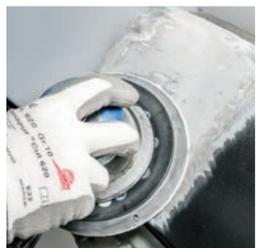
Schleifen mit Schleifmaschine möglich, um die gewünschte Oberflächen-güte zu erzielen
