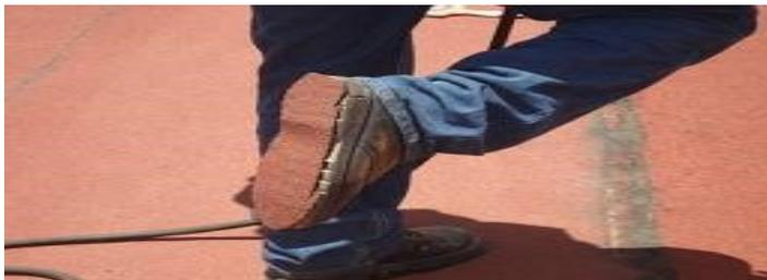
Continuando con la instalación, caliente por medio de soplete de gas (especial para prefabricados), la cara inferior de una sección del manto hasta fundir la película transparente de polietileno que trae integrada, y desenróllelo presionando ligeramente a efecto de que suelde por vulcanización. Repetir esta operación a medida que va extendiendo el rollo de Festermip APP PS Liso.
