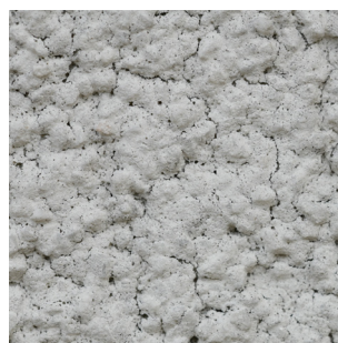
Malter sa mikropukotinama
