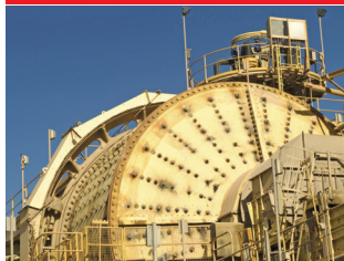
Tourillons des broyeurs à boulets et goulottes d'alimentation
