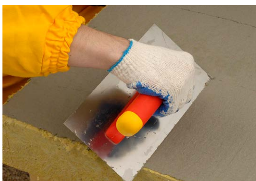
Mineraalvillast soojustus tuleb alati õhukese segukihiga kruntida
