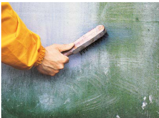
Enne kruntimis puhastatakse aluspind lahtisest tolmust
