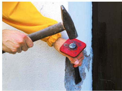
Lahtine krohv ja muud aluspinna pudedad osad tuleb mehhaaniliselt eemaldada
