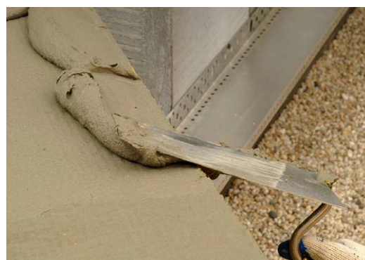
Soojustusplaadi servadele kantud segu peab katma kogu plaadi perimeetri
