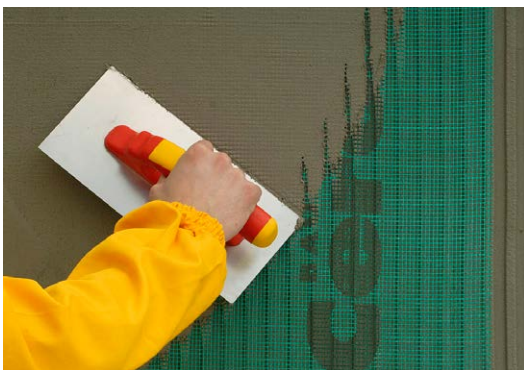
Võrgu paanid paigaldatakse aluspinnale kantud armeerimissegusse
