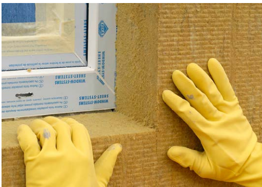
Akende ja uste nurkades kasutatakse L-kujuliselt lõigatud plaate
