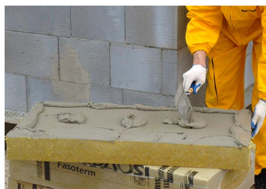
Mineraalvillast soojustus tuleb alati õhukese segukihiga kruntida
