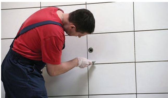
Plaadiservade puhastamine enne vuukimist.
