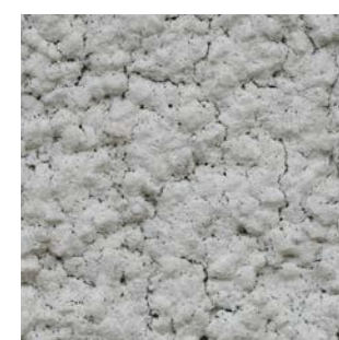
Vakolat mikrorepedésekkel
