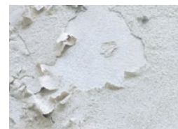
delaminace
