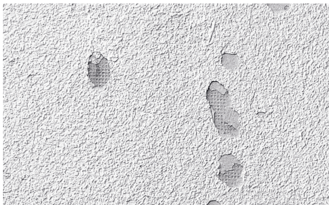
Oštećen malter sa pukotinama zbog niske otpornosti
