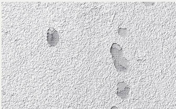
Oštećen malter sa pukotinama zbog niske otpornosti
