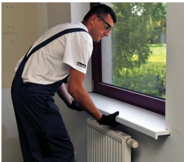
Aknalaua paikaseadmine ja stabiliseerimine
