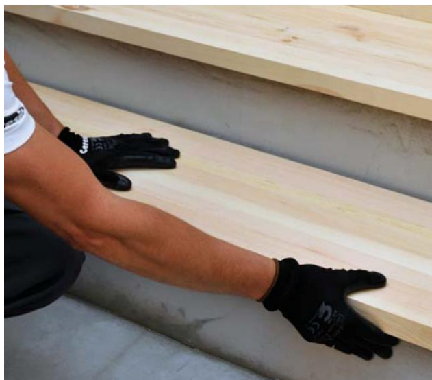
Astmelaua paikaseadmine ja stabiliseerimine
