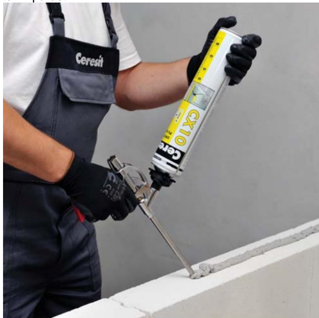
Vahu pealekandmine kärgbetoonplokkide ühendamisel
