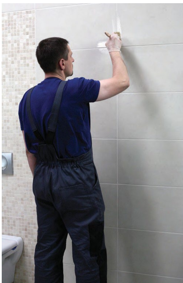
Siūles galima papildomai apsaugoti „Ceresit“ CT 10 silikoniniu impregnantu.
