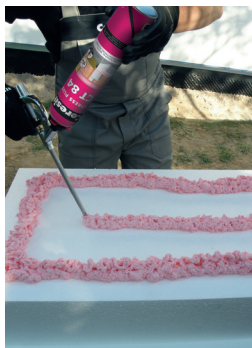
Ugradnja EPS ploča u sistem termoizolacije
