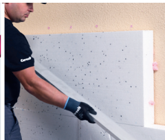
Pričvršćivanje EPS ploča u sistemima "termoizolacija na termoizolaciju"
