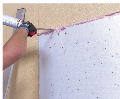
Ispunjavanje spojeva između EPS ploča
