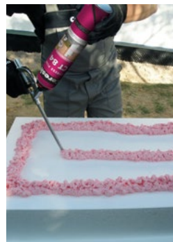
Szigetelőtábla rögzítése a homlokzathoz
