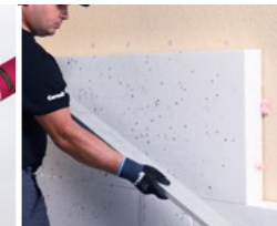
Rögzítés a „rendszer a rendszerre” megoldásokban
