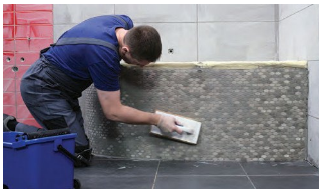
Palaukite. Glaisto formavimą atlikite apvaliais judesiais.
