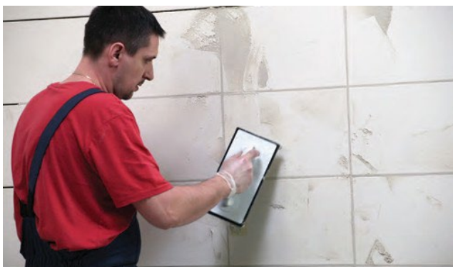
Plytelių siūles kruopščiai užpildykite CE 40 glaistu.
