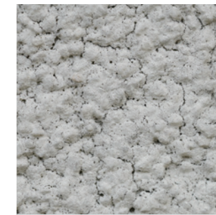
Zaključni sloj z mikrorazpokami
