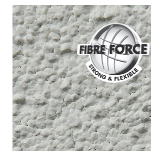
Malter bez mikro pukotina
