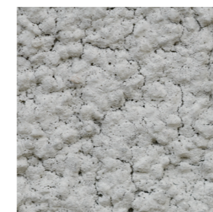
Malter s mikro pukotinama
