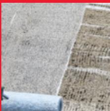
**Primario de uretano de bajo olor y altos sólidos, constituido por dos componentes que deben mezclarse para la aplicación.**
