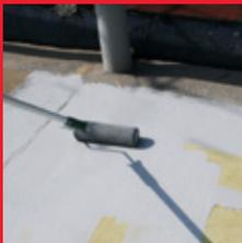
**Recubrimiento de un componente, fabricado con resinas de uretano alifático, base solvente y de altos sólidos que cura con la humedad del ambiente.**
