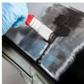
Stesura dello strato protettivo con TEROSON EP 5055
