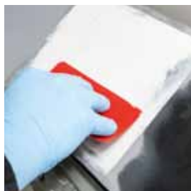
Applicazione di uno stucco poliuretano fine per finitura
