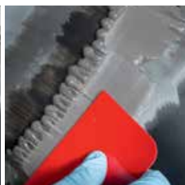
Aplicarea unui strat de TEROSON EP 5010 TR
