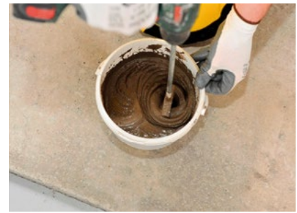
Amestecați cca 30 sec. până la obținerea unui amestec omogen, fără cocloașe
