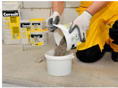
Turnați mortarul în apă
