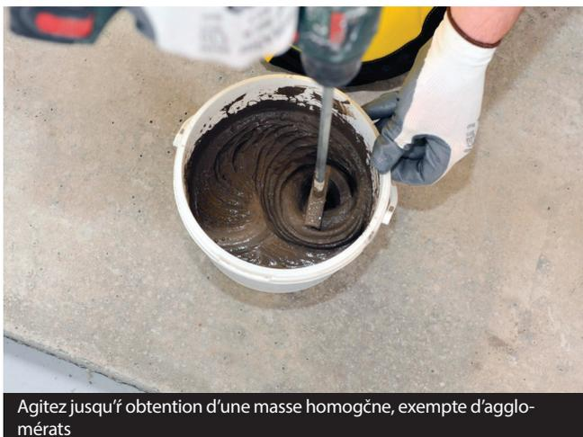
Agitez jusqu'à obtention d'une masse homogène, exempte d'agglomérats
